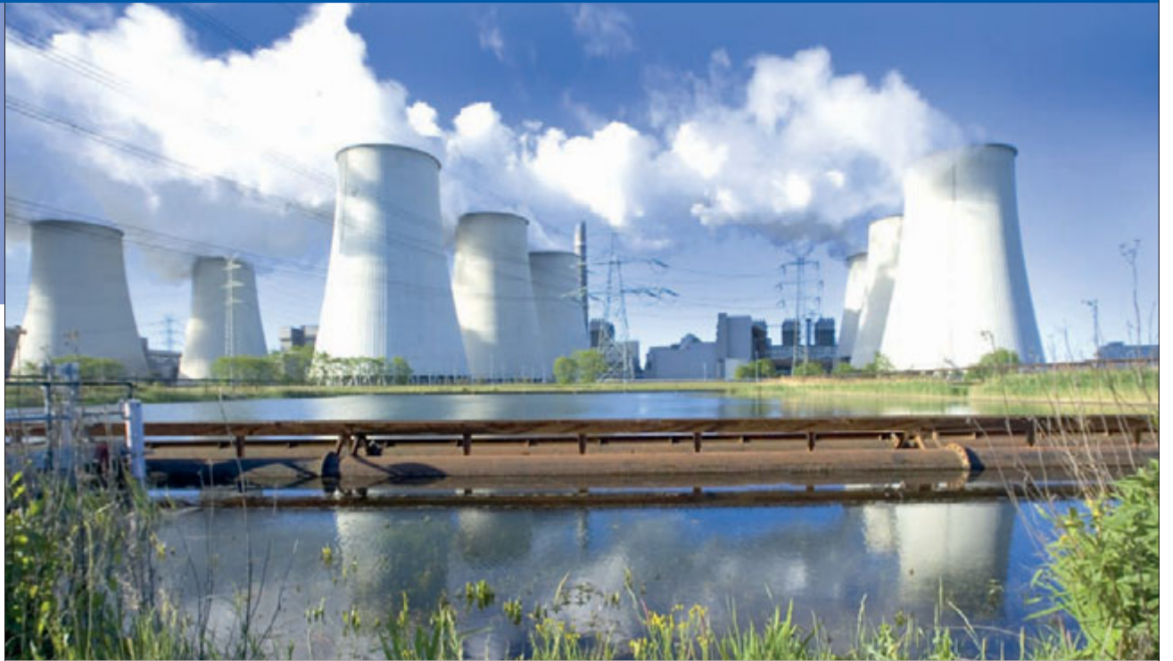
Braunkohlekraftwerk Jämschwalde in der Niederlausitz
